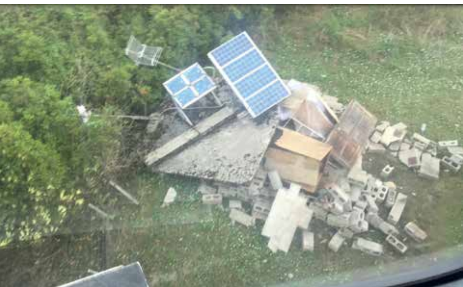
Fig. 5 - Vista dall'elicottero dei danni subiti dalla stazione GPS francese GUMB. Né il ricevitore GPS né l'antenna hanno subito danni.
