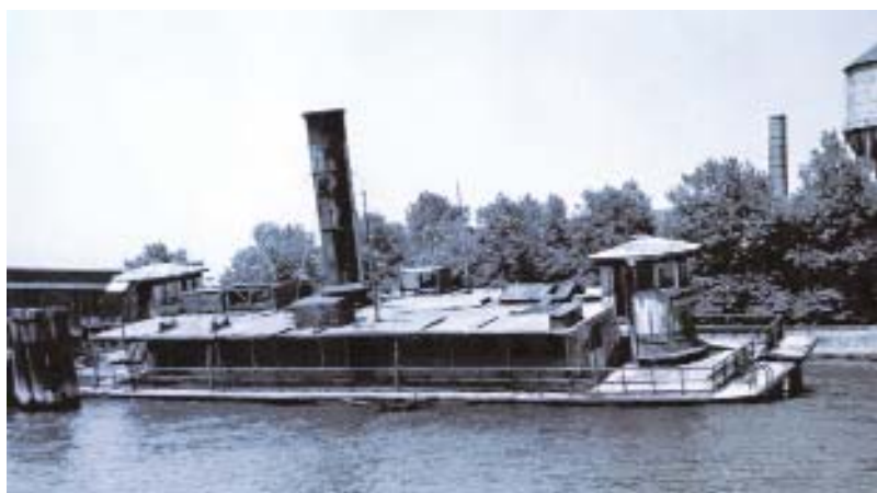
Qui sopra: nel 1968 il traghetto, all'ancora ormai da tempo, si appoggiò sul fondo del bacino di attracco. In alto: un tecnico al lavoro su Ellis Island con strumentazione GPS
