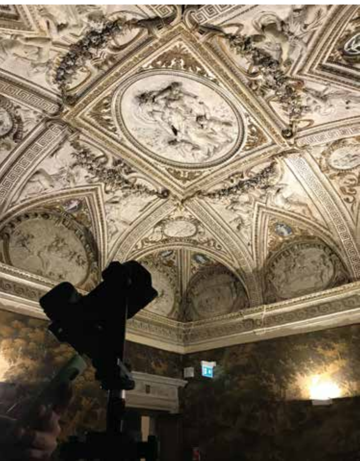
Fig.1 - Vista di uno dei soffitti stuccati di Palazzetto Baviera, Senigallia.
