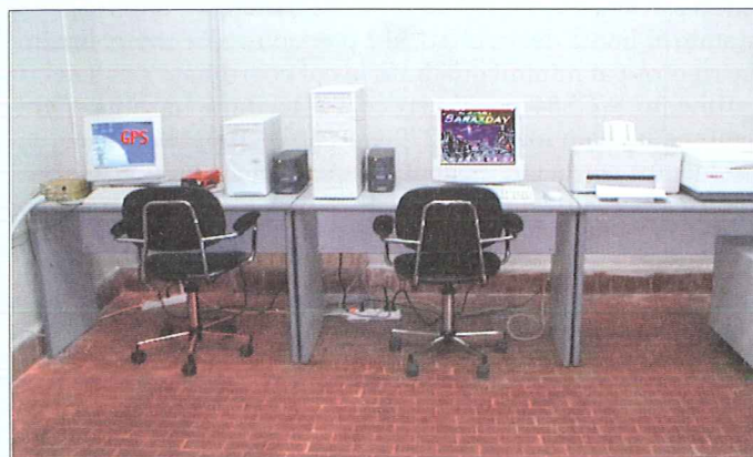
STAZIONE PERMANENTE GPS "TGRC" ISTITUTO TECNICO STATALE PER GEOMETRI "A. RIGHI" REGGIO CALABRIA
