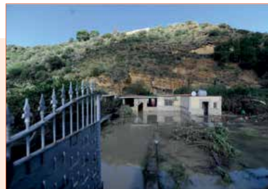
Fig. 2 - Fabbricato in territorio di Casteldaccia.
