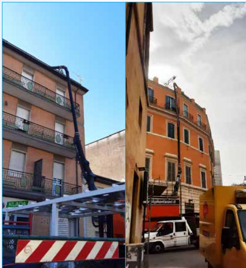
Impieghi civili dell'escavatore a suzione – aspirazione di materiali in quota
