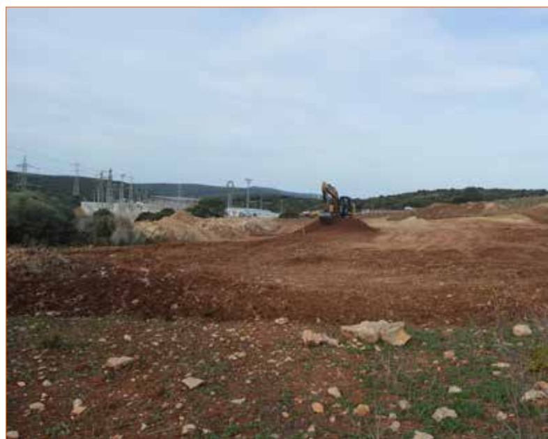
Fig. 1 - operazioni di scavo per un impianto eolico (Loc. Monte Rosè, Porto Torres-SS)- Foto dell'Autore.
