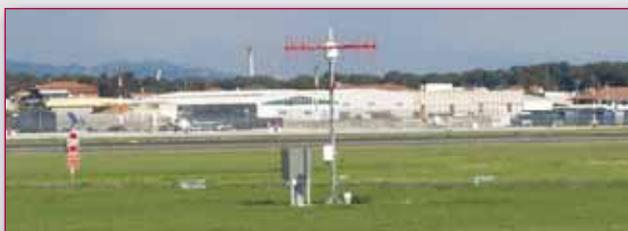
Pur operando in maniera passiva, il VHF Direction Finder, noto anche come radiogoniometro, è ancora presente in tutti gli aeroporti. Legame più antico con gli albori della radio, permette agli operatori della Torre di Controllo di comunicare ad un pilota, in base alle sue trasmissioni, la propria direzione rispetto al campo di volo.
