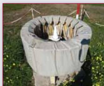
Dettaglio di una delle due antenne GPS della RIMS EGNOS di Catania. La semplicità dell'installazione fa trascurare la complessità del sistema che opera sull'intera estensione europea e che potrà essere espanso anche al bacino del Mediterraneo.
