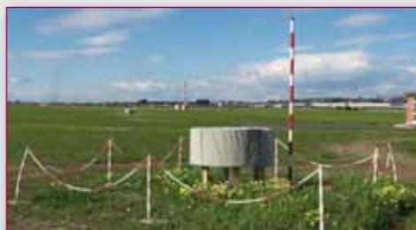
Una delle due antenne della RIMS di EGNOS di Catania, con sullo sfondo l'antenna della Guida Planata (Glide Path) dell'impianto di atterraggio strumentale (ILS). EGNOS è un elemento chiave per dotare di avvicinamenti strumentali di precisione anche gli aeroporti, o le direzioni di atterraggio, non dotati di ILS.
