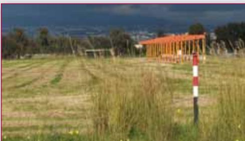
Anche se non nella stessa zona delle precedenti, l'ampia antenna del Localizzatore è parte dell'impianto ILS per la pista 06 a Catania. La possibilità di eseguire avvicinamenti di precisione è la chiave per lo sviluppo di un aeroporto moderno: usare EGNOS come alternativa abbatterebbe il costo di esercizio dell'impianto con notevoli benefici soprattutto per gli aeroporti medio/piccoli.
