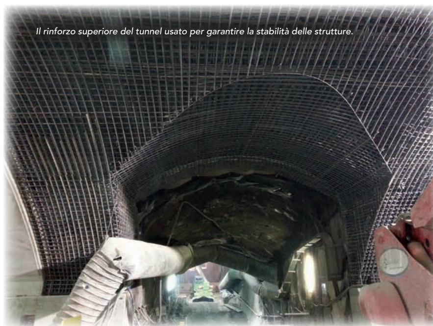
*Il rinforzo superiore del tunnel usato per garantire la stabilità delle strutture.*
