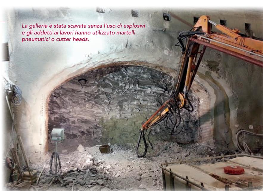
*La galleria è stata scavata senza l'uso di esplosivi e gli addetti ai lavori hanno utilizzato martelli pneumatici o cutter heads.*
