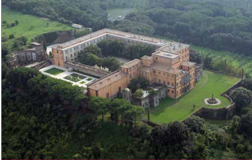
Fig. 2 - Foto aerea dell’intero complesso della Villa .
