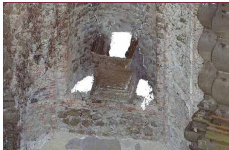
Fig. 7 - Modello tridimensionale di uno dei piedistalli del Ninfeo rilevato con laser scanner. Si notino i vuoti di informazioni.
