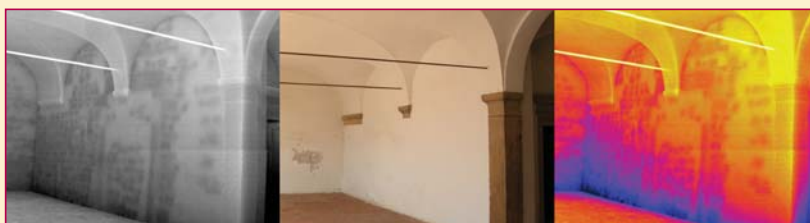
Figura 2- Immagine termografica in falsi colori e scala di grigio della loggia inferiore di Villa Del Bene a Volargne (Dolcè - VR). Il primo termogramma mostra la presenza di una apertura tamponata e ora non più visibile poiché coperta dall'intonaco di finitura, mentre i falsi colori evidenziano problemi di risalita capillare alla base della parete.
